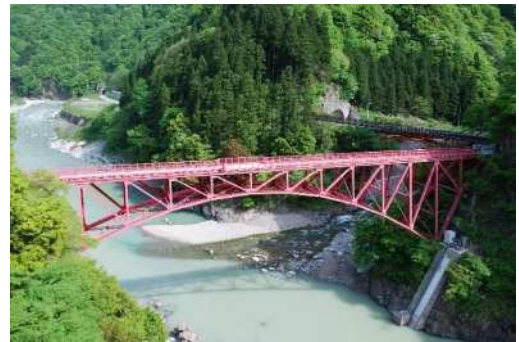
旧山彦橋（上流から）
