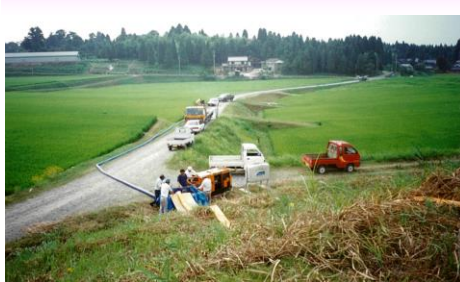
ため池への送水管の設置
