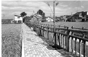
溶融スラグを有効利用したインターロッキングブロック（富山県認定リサイクル製品）
