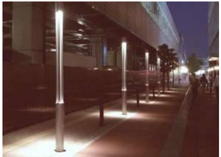
新設街路灯の改修 (イメージ)
