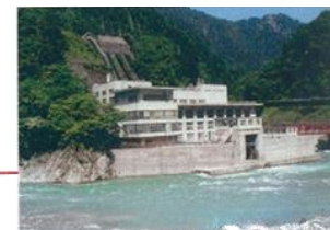
黒部川第二発電所
