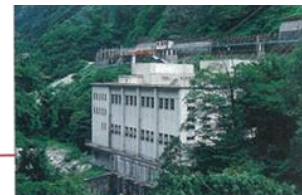
黒部川第三発電所
