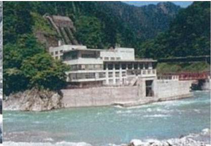
黒部川第二発電所
