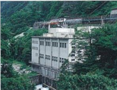
黒部川第三発電所
