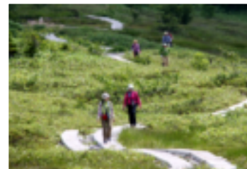
弥陀ヶ原の木道再整備
