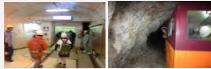
縦坑エレベーター
