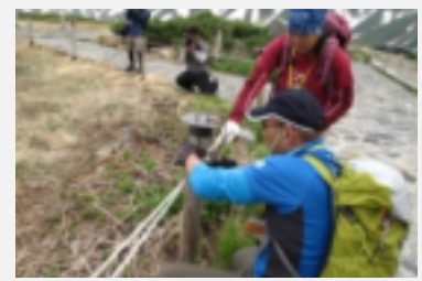
ライチョウ保護柵の設置
