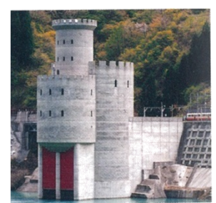
新柳河原発電所
