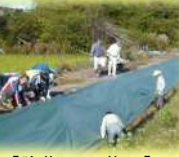
【防草シート施工】
