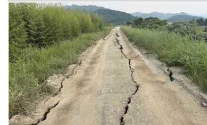
ひろつがわ 広渡川水系広渡川の堤防天端の亀裂（宮崎県日向市）
