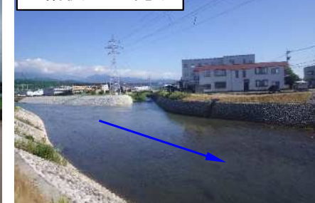
整備後 H31完成
