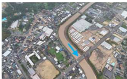
かわらだ 河原田川水系河原田川の浸水状況（石川県輪島市）
