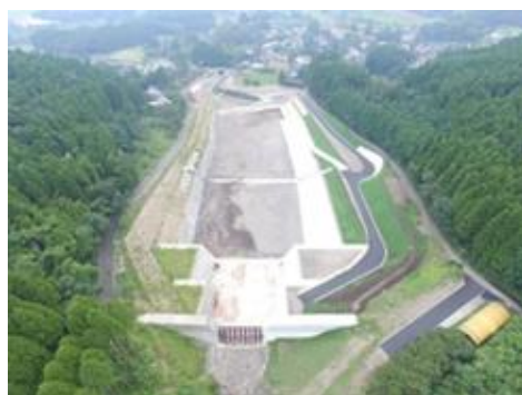
祓川水系 祓川遊砂地 九州地方整備局 宮崎河川国道 事務所HPから流用
