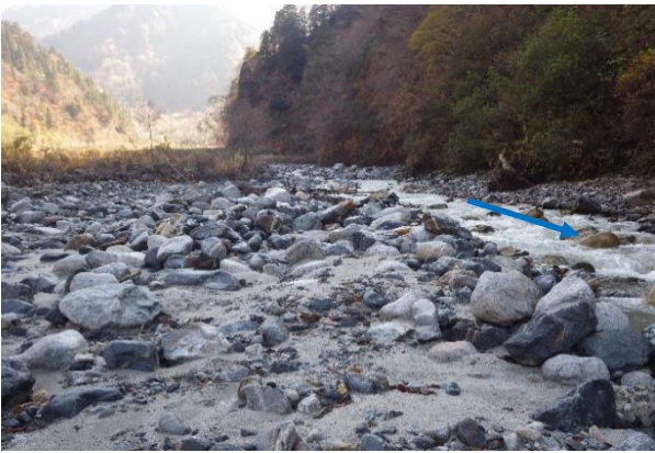
② 上流域不安定土砂の堆積状況
