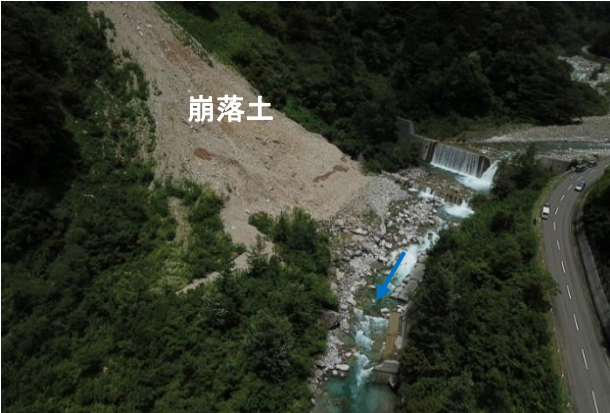
① 上流支川荒廃状況
