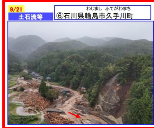
塚田川(石川県輪島市久手川町)
