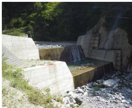
常願寺川水系 雑穀谷10号堰堤
