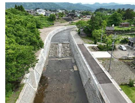
小矢部川水系 池川護岸工
