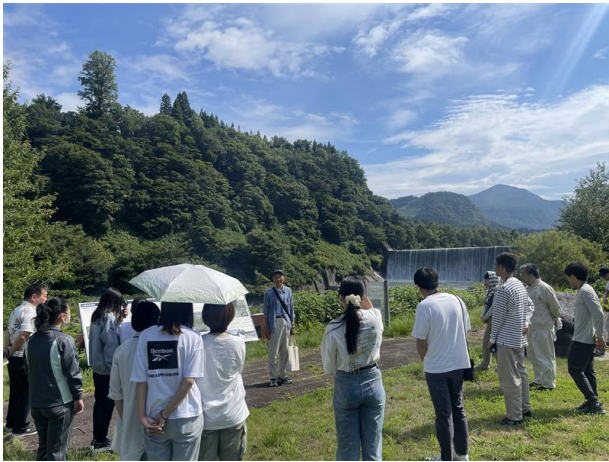
現地視察（本宮堰堤）
