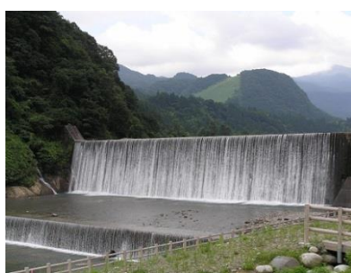
本宮堰堤（昭和 11 年竣工）
