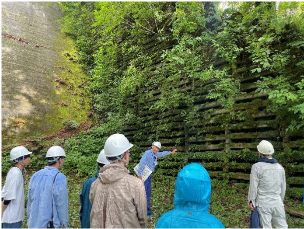
現地視察（白岩堰堤 方格柵）
