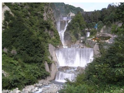
白岩堰堤（昭和 14 年竣工）
