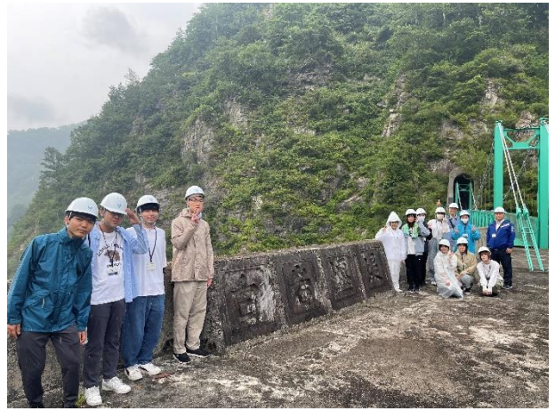
現地視察（白岩堰堤）
