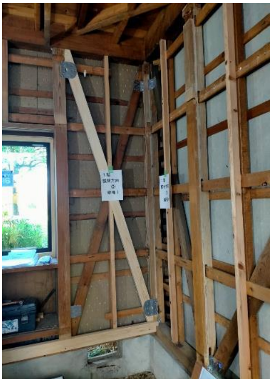
耐震改修工事現場
