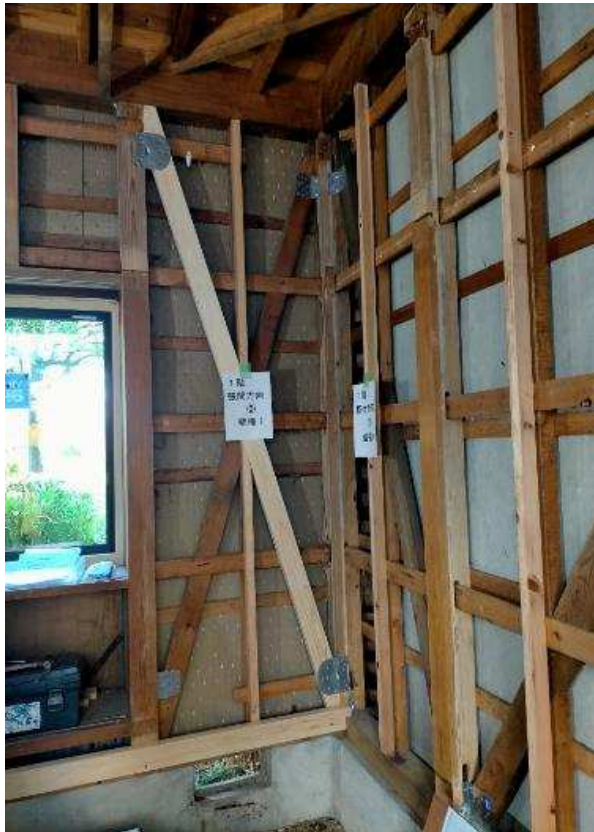
耐震改修工事現場
