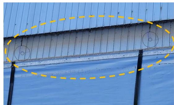
図11 独自に設置された光反射ディスク
