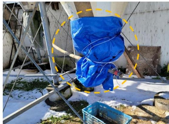
図9 破損箇所を修復した飼料タンク
