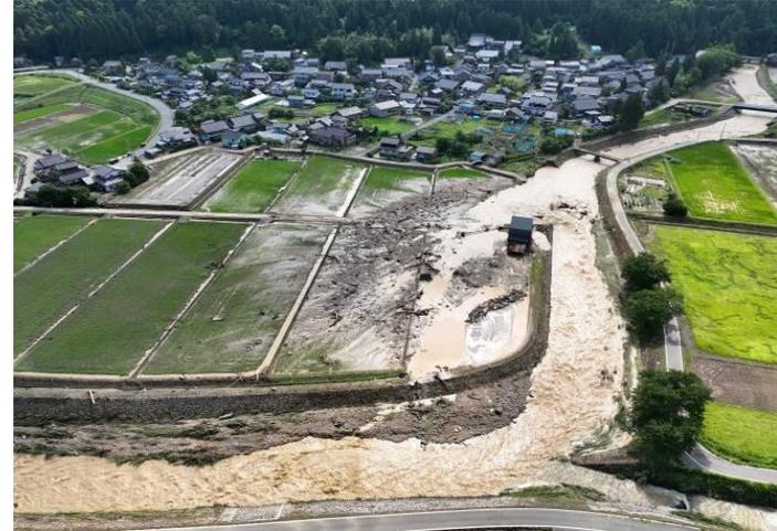
白岩川の護岸欠損による被災状況
