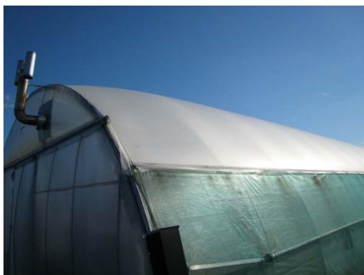
空気膜2重被覆（屋根部）
