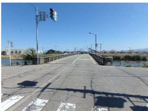
水橋大橋左岸側より
