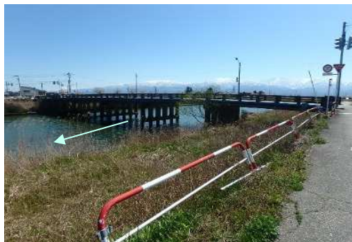
水橋大橋左岸側より
