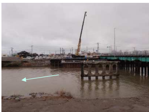
工事中左岸側より
