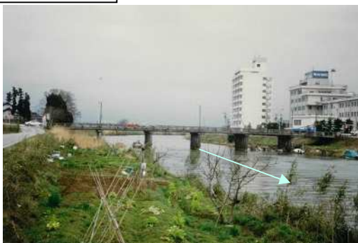
水橋大橋右岸側より
