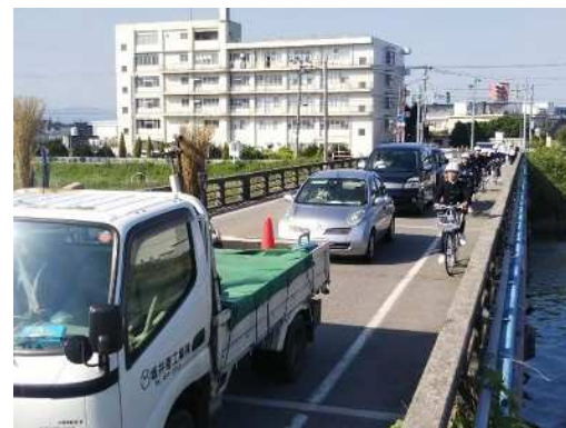
水橋大橋右岸側より
