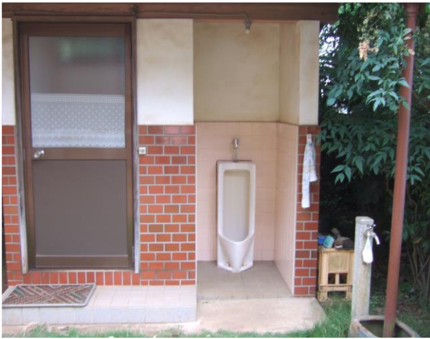
図1 トイレ・手洗い設備の設置
