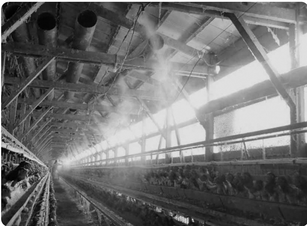
養鶏場で稼働中の細霧装置
