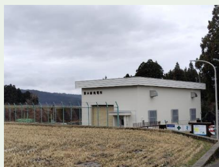
上流の既設水力発電所
