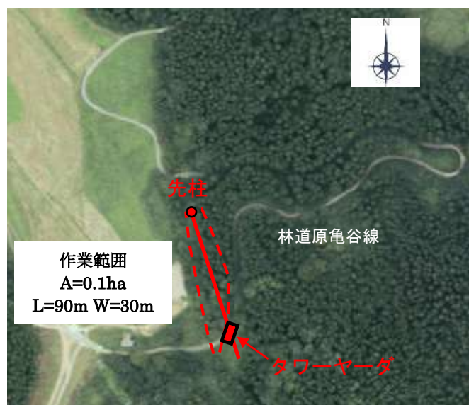
タワーヤーダ設置状況（航空写真）
