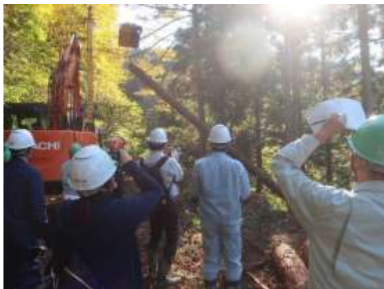
タワーヤーダによる集材
