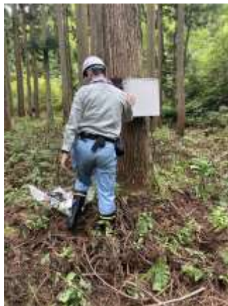
林業パッケージ（拡張）の設置状況
