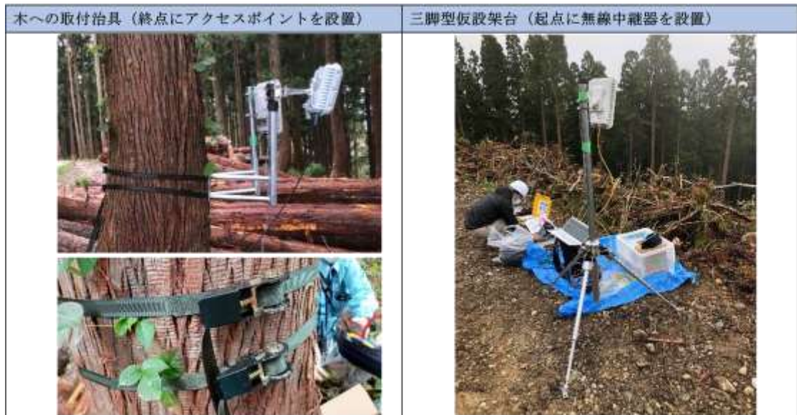
図-27 設置状況（設置器具）
