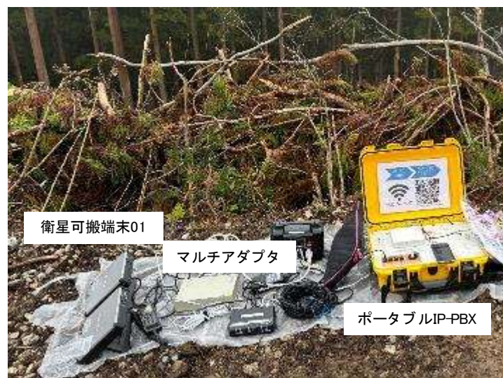
図-23 設置状況（衛星携帯電話網の活用）
