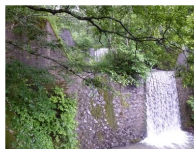
泥谷堰堤（昭和 13 年竣工）
