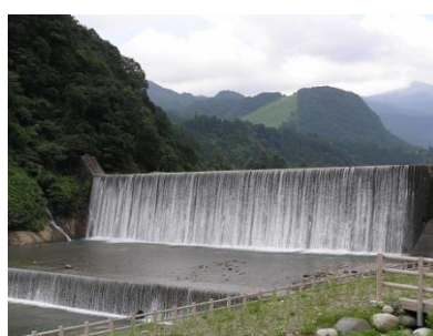
本宮堰堤（昭和 11 年竣工）
