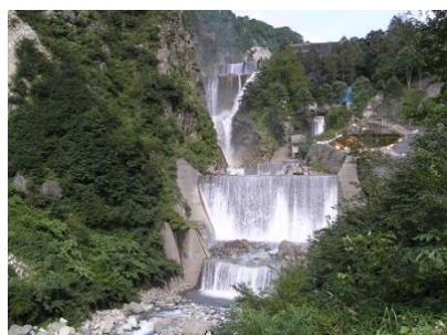
白岩堰堤（昭和 14 年竣工）
