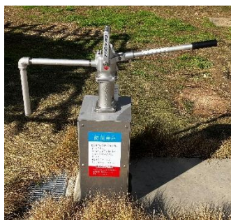
防災井戸 (県庁舎敷地内)
