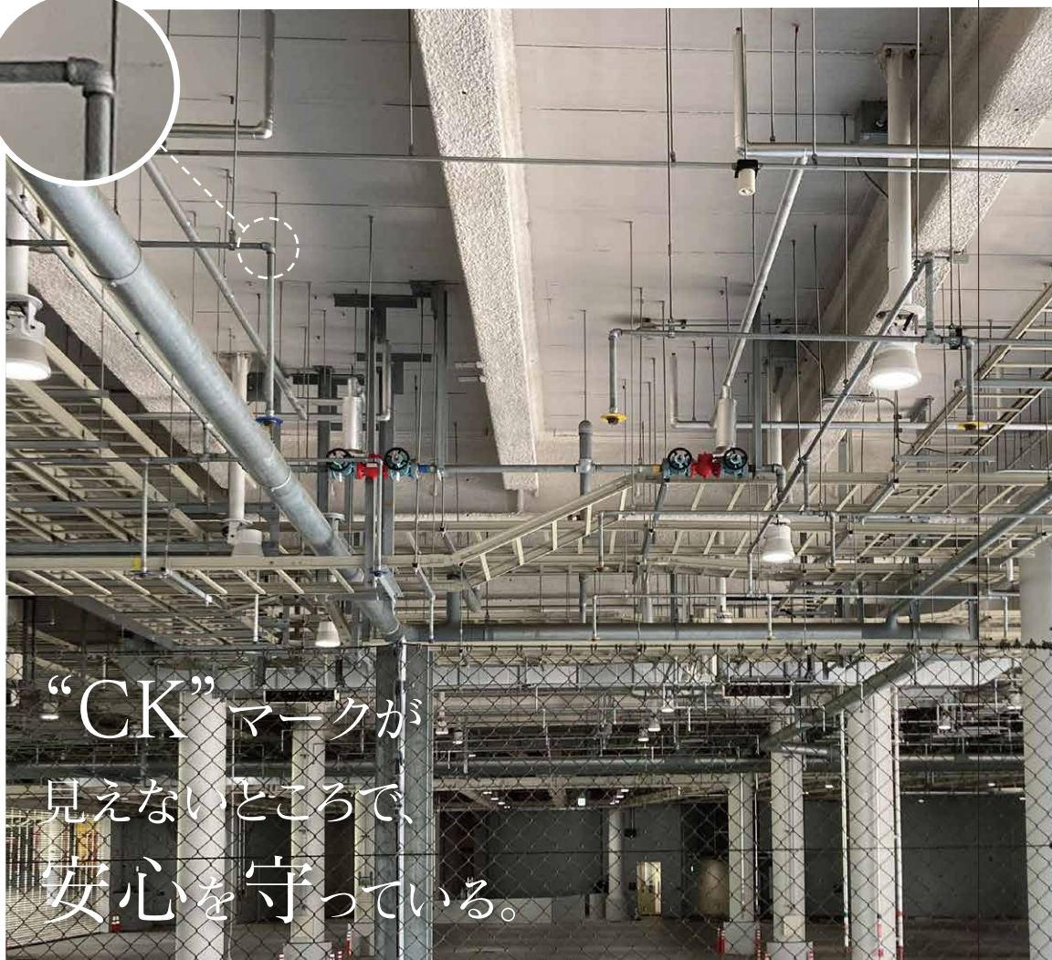
国立競技場(東京都新宿区)地下駐車場の消火設備配管にはCKマークの継手が採用された。
