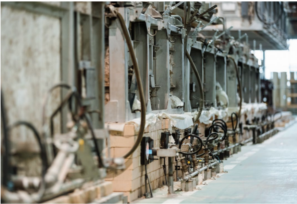
国内最大クラスの4m×10mの曲げ加工炉。建物やオブジェなどの大型ガラスの加工で威力を発揮する。
