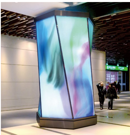
アーティストの要望にも3次元曲面成型加工ガラスで実現。台湾松山駅「路標」・多田美波研究所(新光硝子工業株式会社)
