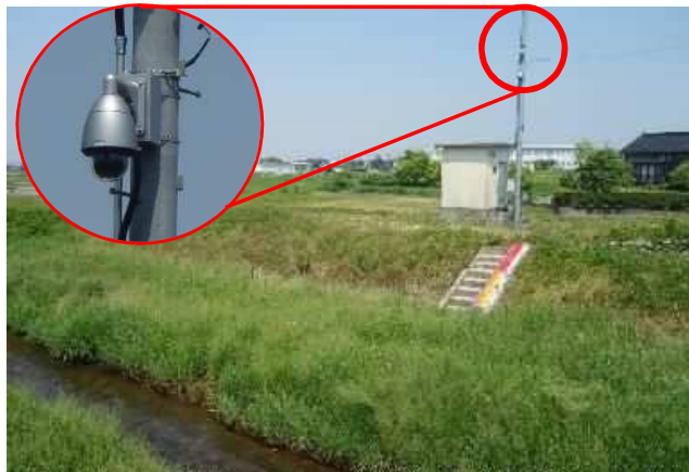
河川監視カメラ設置状況
