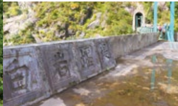
▲白岩砂防堰堤の銘板と管理橋
