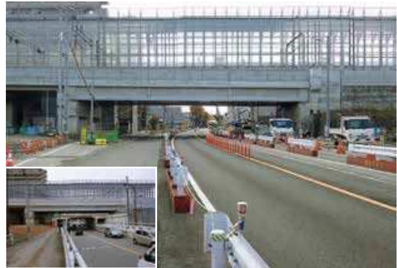
大鉄工業・高田組富山駅付近連続立体交差事業牛島地下道撤去工事 共同企業体施工の「富山駅付近連続立体交差事業牛島地下道撤去工事」
