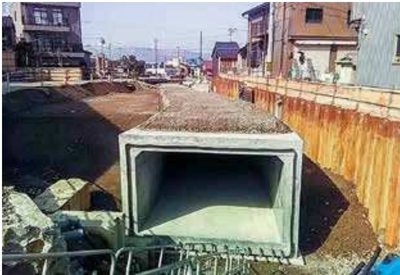
(株)藤井組施工の「都市計画道路谷今町線街路総合交付金函渠工事」
