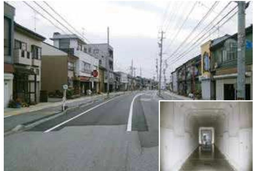
(株)東城施工の「鴨川河川改修放水路工工事」
