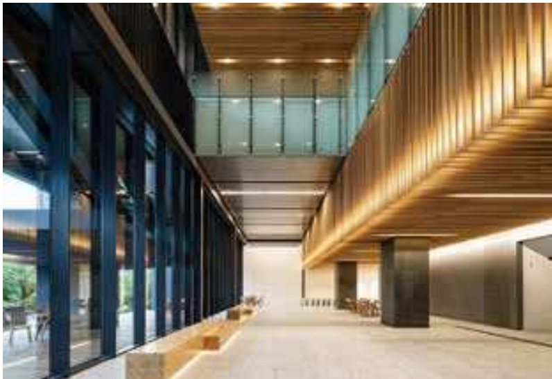
北陸電気工事・ケイ電工富山県防災・危機管理センター（仮称） 新築電気設備工事共同企業体施工の「富山県防災・危機管理 センター（仮称）新築電気設備工事」
