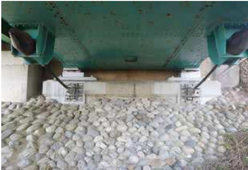
佐藤鉄工(株)施工の「主要地方道魚津生地入善線道路橋りょう改築 下黒部橋橋梁補修第5工区工事」
