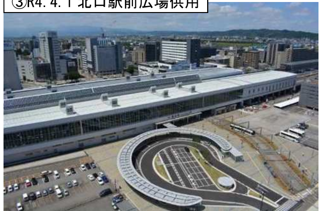
③R4. 4. 1 北口駅前広場供用
