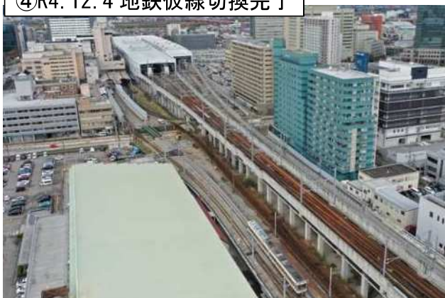
④R4. 12. 4 地鉄仮線切換完了
