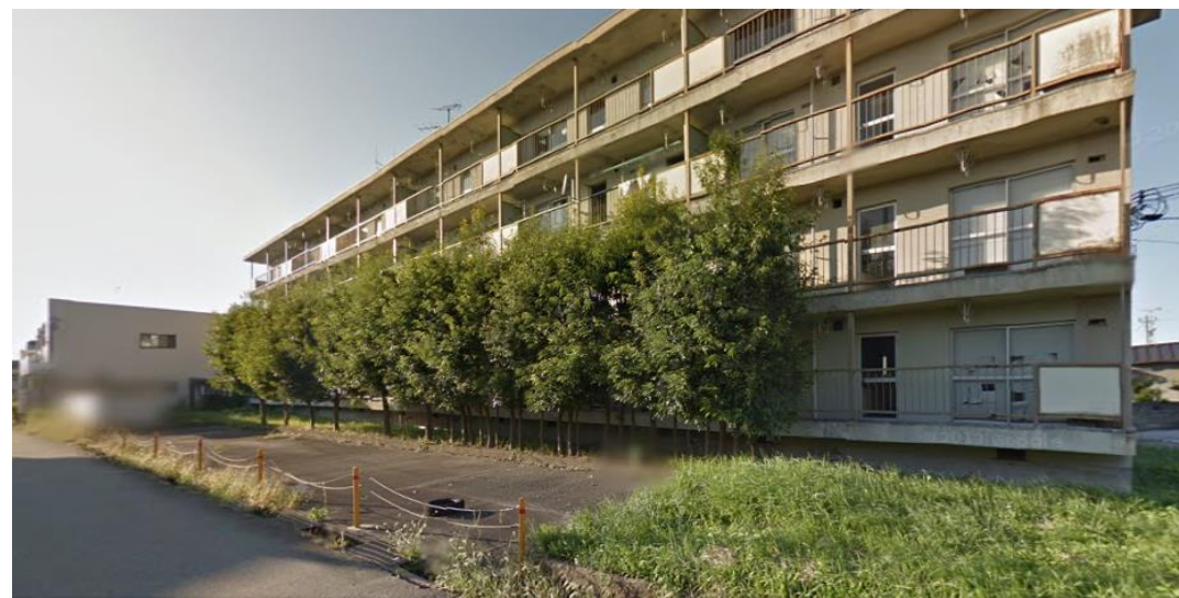
※建物解体前の写真
