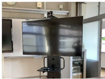
（遠隔システム用モニターとカメラ） ※天井にマイクや教員用モニター、教室後方に教室全体を撮影するカメラなどが設置。
