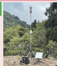
林内通信環境の整備
