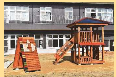
屋外遊具の設置 (富山市西大沢)
