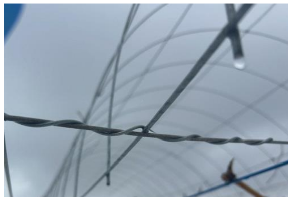
図39 交差クリップによるトンネルメッシュの固定
