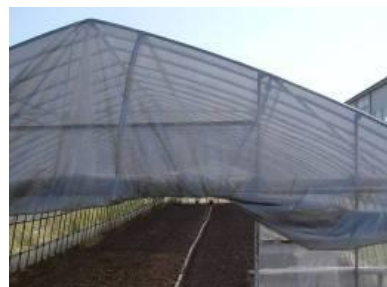
図 11 天井ビニルへの遮光資材被覆
