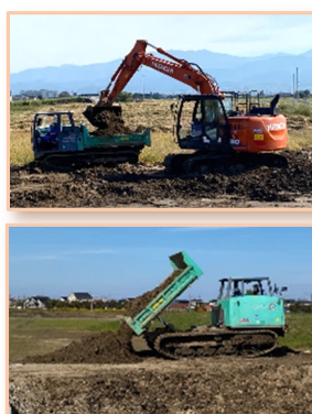
整地作業中の様子
