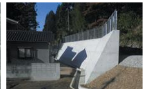
急傾斜地崩壊対策事業 栃津地区
