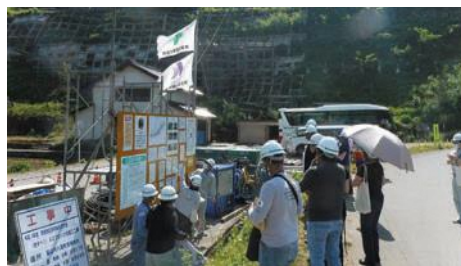
現場視察(急傾斜地崩壊対策事業:富山市八尾町青根)
