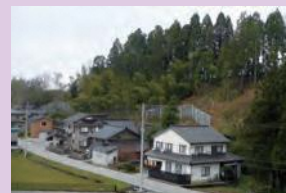
急傾斜地崩壊対策事業 本江(2)地区
