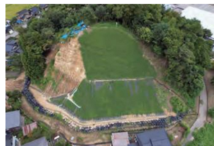
(急傾斜地崩壊対策事業) 園(2)地区
