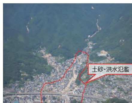
土砂・洪水氾濫の発生事例（国土交通省HPより）
