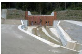
田川谷内川砂防堰堤（R6.3）
