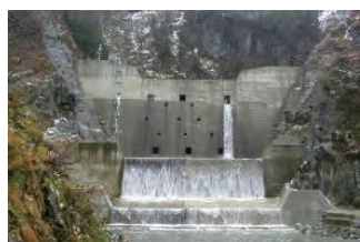
【完成した12号砂防堰堤】
