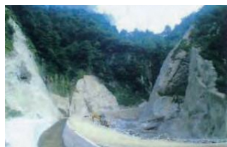
【掘削が完了した本堤部】
