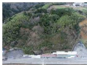
道の駅雨晴(H14までに法枠+待受式擁壁工を設置)
