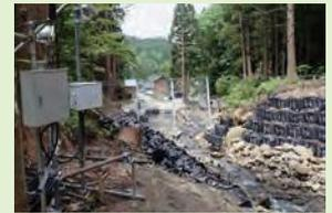
県内初の土石流後のアンカーネット工の設置(立山町中谷川)
