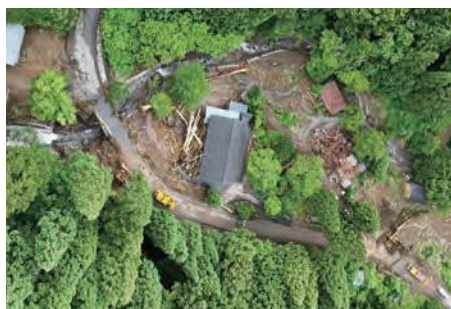
写真1：立山町中谷川での土石流
