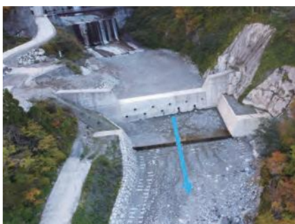
常願寺川水系雑穀谷13号堰堤
