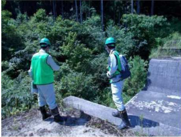
管理型砂防堰堤の緊急点検状況
