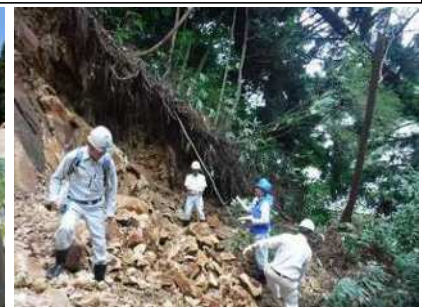
災害復旧技術専門家2名（青い服）による 現地調査
