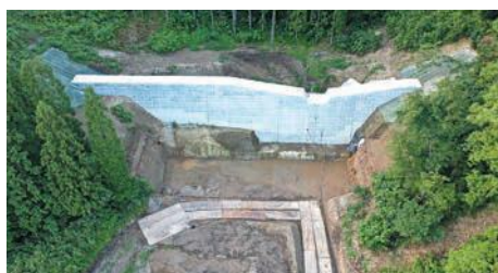
五十里道重(2) 砂防堰堤 本体完成
