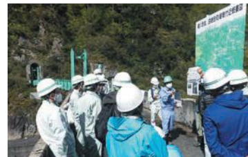
白岩砂防堰堤にて
