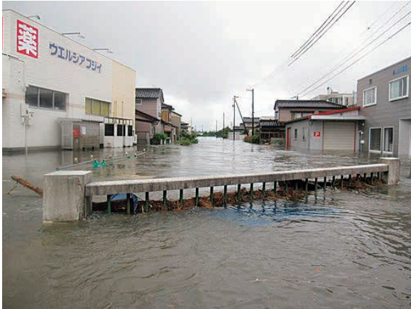
地久子川 [平成24年7月 高岡市]
