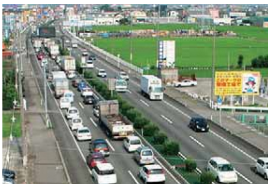
富山外郭環状道路 豊田新屋立体 (現道 (国道8号) 状況)
