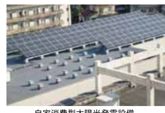
自家消費型太陽光発電設備
