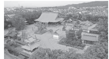
勝興寺修理後全景
