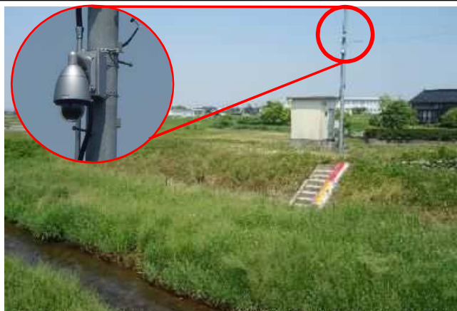
河川監視カメラ設置状況
